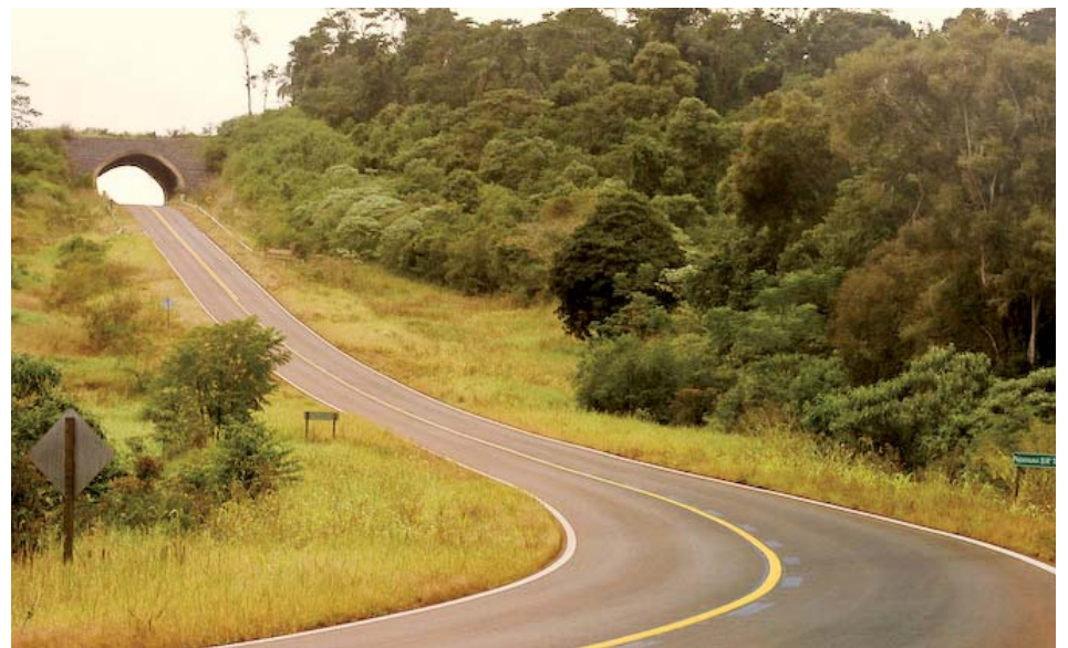
Los ecoductos son puentes disfrazados con vegetación de la zona que les permiten a las especies más grandes cruzar las rutas sin tocar el asfalto. Ecoductos como este construido en Misiones, podrán mitigar el daño producido en las especies como guanacos, producto de la construcción de carreteras.
